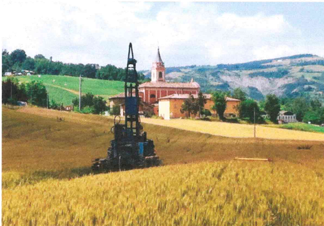
Figura 9. Esecuzione del sondaggio geognostico.
