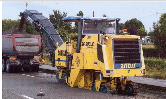
fig. 01 – Operazioni di scarifica in sede stradale
