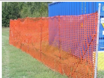
Rete plastificata in HDPE su rete metallica su supporto in cls.
