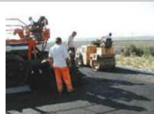
fig. 01 – Operazioni di finitura manto stradale
