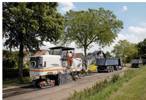
fig. 03 – Scarifica con macchine di grande dimensioni in strada chiusa
