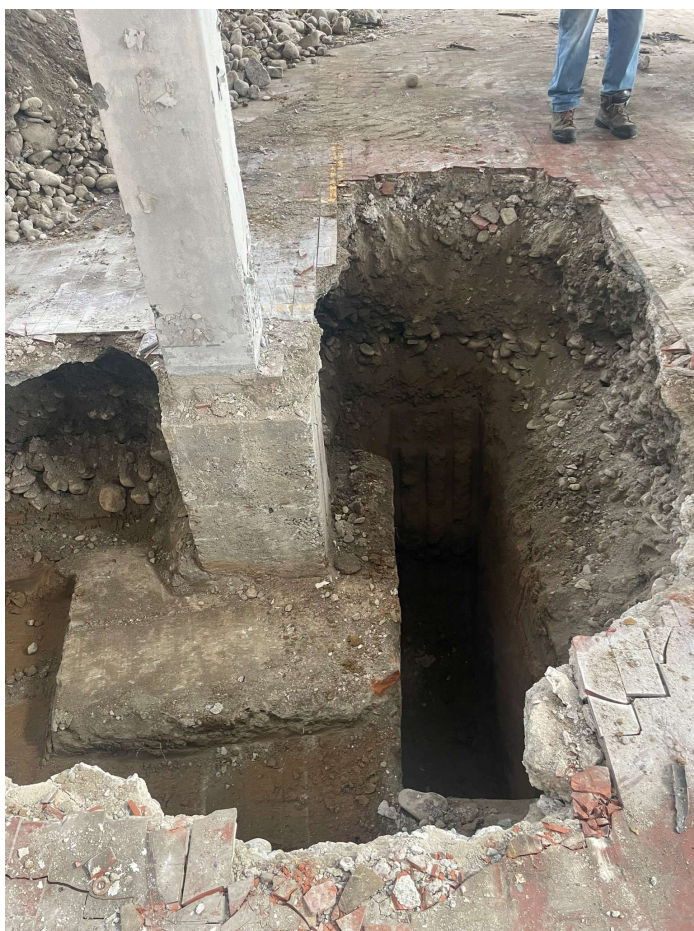
Figura 2. Plinti della vecchia porzione degli edifici (plinti di tipo A). Essi sono composti di un bicchiere e di un basamento . Il bicchiere su cui poggia il pilastro in calcestruzzo armato inizia 12 cm sotto la quota del pavimento (quota 0), dimensioni in pianta 50 cm x 50 cm e profondità 82 (più i 12 cm della porzione di pilastro sottoterra). Il basamento è un parallelepipedo di conglomerato di cemento, gettato in una cassaforma a perdere in laterizio; la sua superficie superiore è a 94 cm dalla quota del pavimento (quota 0); le dimensioni in pianta sono 125 cm x 135 cm e profondità 160 cm. Il bicchiere è circondato da un terreno di riporto in ciottoli di fiume e sabbia, compattato, il tutto coperto con un massetto di 12 cm e da piastrelle in gres porcellanato. Il basamento è immerso nel suolo naturale, costituito di arenaria/argilla. I saggi sono stati eseguiti con mezzi meccanici dal sig. Dino Rinaldi di Sasso Marconi.
