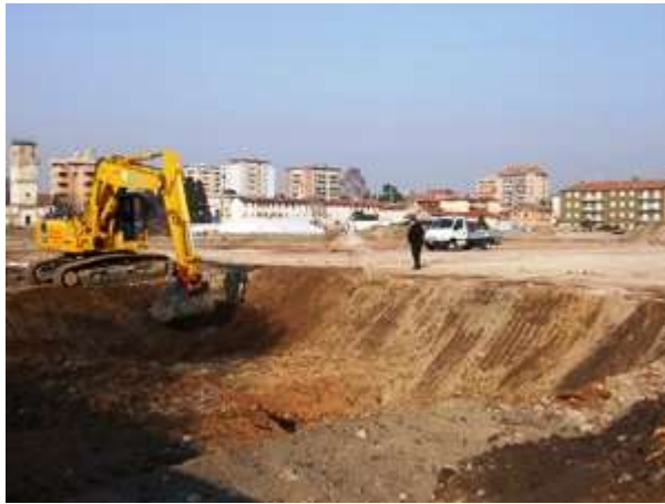
Figura 6. Bordi degli scavi a stabilità naturale. L'intervento di rimozione delle fondazioni deve essere eseguito senza dover realizzare opere di sostegno.
