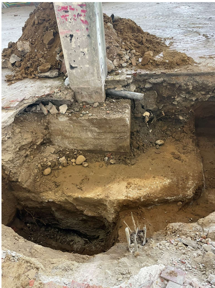
Figura 3. Plinti dei capannoni più recenti, posti a Sud e a Ovest dell'area (plinti di tipo B). Anch'essi sono composti di un bicchiere e di un basamento . Il bicchiere su cui poggia il pilastro in calcestruzzo armato inizia 15 cm sotto la quota del pavimento (quota 0), dimensioni in pianta 130 cm x (32 + 50 + 32) = 114 cm e profondità 78 (più i 15 cm della porzione di pilastro sottoterra). Il basamento è un parallelepipedo di conglomerato di cemento, gettato direttamente nel terreno; la sua superficie superiore è a 93 cm dalla quota del pavimento (quota 0), dimensioni in pianta (100 + 130 + 100) = 330 cm x (40 + 114 + 40) = 194 cm e profondità 125 cm. Il bicchiere è circondato solo in parte della sua profondità da un terreno di riporto in ciottoli di fiume e sabbia (il resto è il suolo originario), compattato, il tutto coperto con un massetto di 15 cm, comprese le piastrelle in gres porcellanato. Il basamento è immerso nel suolo naturale, costituito di arenaria/argilla.
