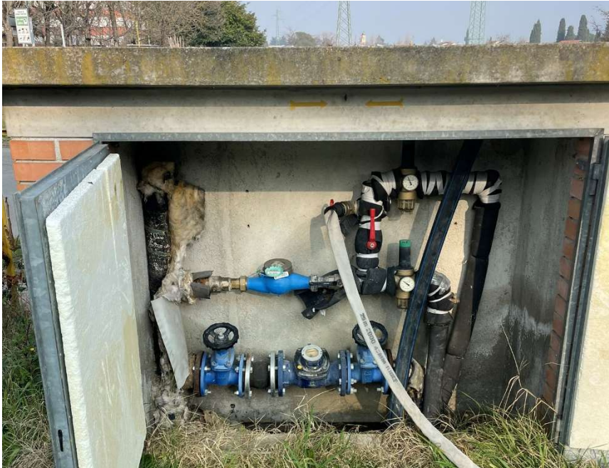
Figura 10. Manufatto che contiene i contatori dell'acquedotto che serve il magazzino comunale, situato in corrispondenza dell'accesso da via Ponte Albano 16. A partire da questo contatore è possibile collegare sia i bagni del cantiere sia l'impianto dei cannoni d'acqua per abbattere le polveri nel corso della demolizione dei manufatti.
