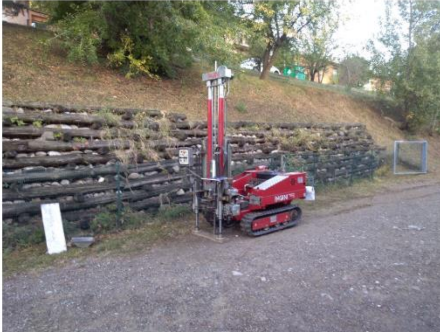
Figura 6: esecuzione prova penetrometrica P1
