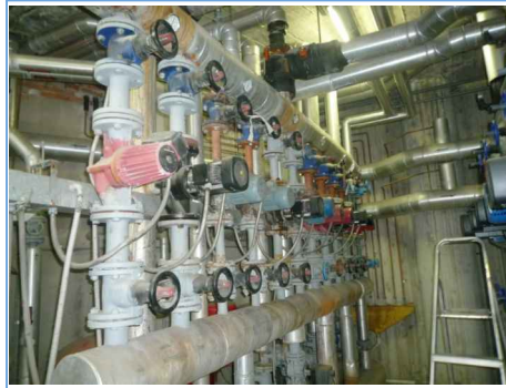
FOTO DELLO STATO ATTUALE: Collettori di mandata e ritorno acqua calda di riscaldamento ubicato in Centrale Termica
