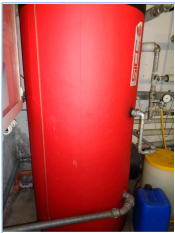
FOTO DELLO STATO ATTUALE: Boiler verticale con scambiatore estraibile Marca: SICC Capacità: 800 Lt.
