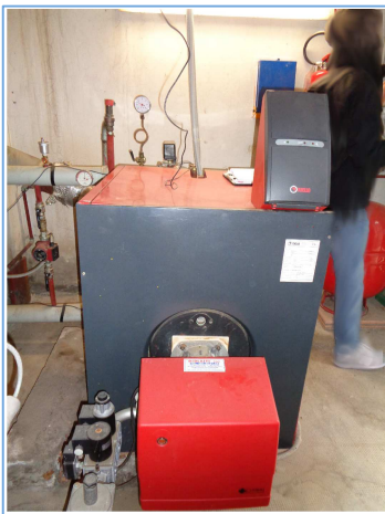
FOTO DELLO STATO ATTUALE: Generatore di calore a gas metano. Marca: RIELLO Modello: 4RC76 Potenza Utile: 103,5 kW Potenza Focolare: 114,8 kW Anno costruzione: 1999
