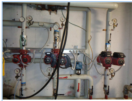
FOTO DELLO STATO ATTUALE: Circuiti di mandata e ritorno acqua calda di riscaldamento
