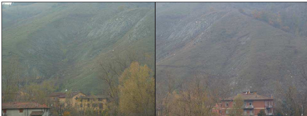
Area d'indagine - Panoramica dei due impluvi principali oggetto d'intervento
