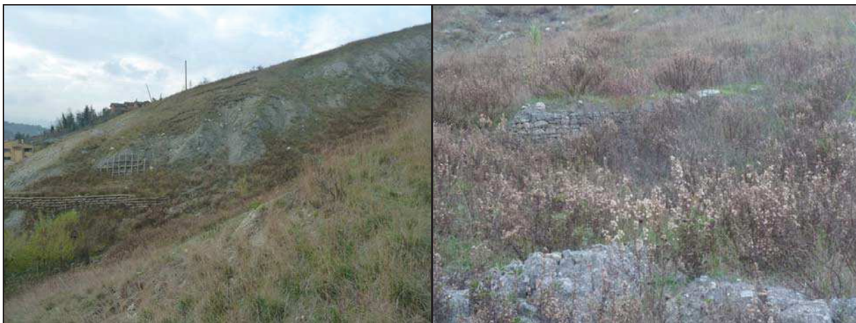
Interventi di consolidamento sul calanco posto a Sud Ovest
