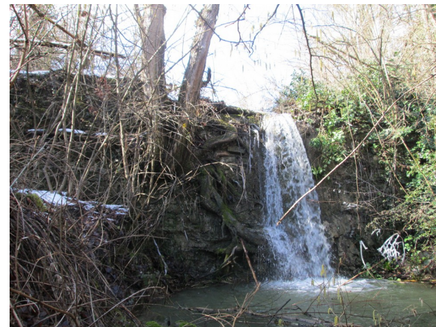
Foto 1-3 Rio della Cavanella: presenza di ricca vegetazione arbustiva ed arborea crollata in alveo e nelle immediate vicinanze, ridotta sezione idraulica in alcuni tratti, manutenzione manufatti idraulici esistenti mediante ripristini copertine, paramenti, realizzazioni rampe e platee in scogliera di pietrame ciclopico, ripristino gabbionate, taglio di vegetazione interferente con il deflusso idraulico
