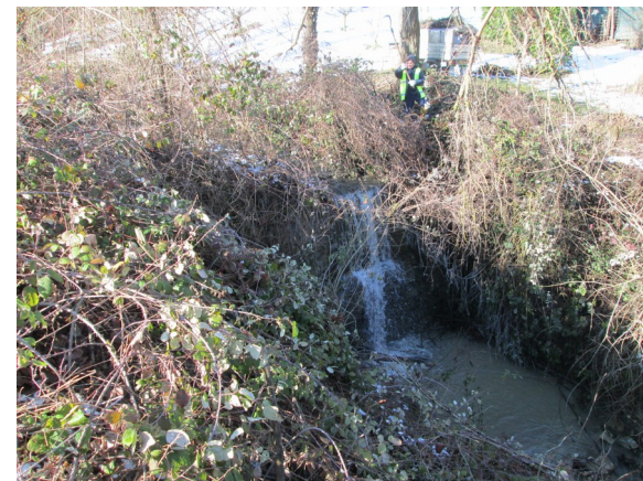
Foto 1-3 Rio della Cavanella: presenza di ricca vegetazione arbustiva ed arborea crollata in alveo e nelle immediate vicinanze, ridotta sezione idraulica in alcuni tratti, manutenzione manufatti idraulici esistenti mediante ripristini copertine, paramenti, realizzazioni rampe e platee in scogliera di pietrame ciclopico, ripristino gabbionate, taglio di vegetazione interferente con il deflusso idraulico
