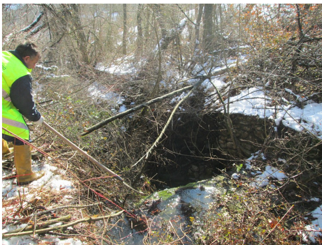
Foto 1-3 Rio della Cavanella: presenza di ricca vegetazione arbustiva ed arborea crollata in alveo e nelle immediate vicinanze, ridotta sezione idraulica in alcuni tratti, manutenzione manufatti idraulici esistenti mediante ripristini copertine, paramenti, realizzazioni rampe e platee in scogliera di pietrame ciclopico, ripristino gabbionate, taglio di vegetazione interferente con il deflusso idraulico
