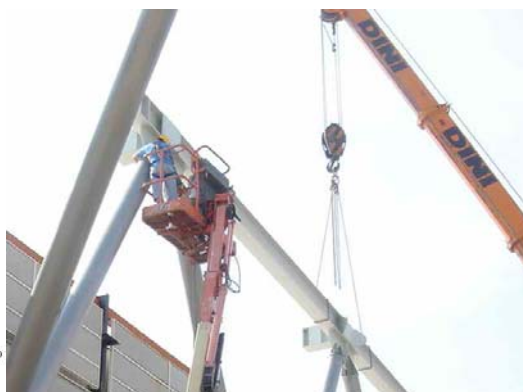
Esempio di sistema anticaduta con uso di imbracatura - fune di sospensione avvolgitore - ancoraggio
