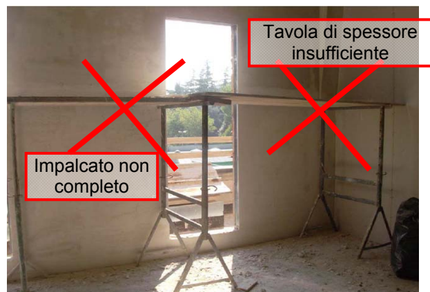
Esempio di errori comuni nella realizzazione dei ponti
