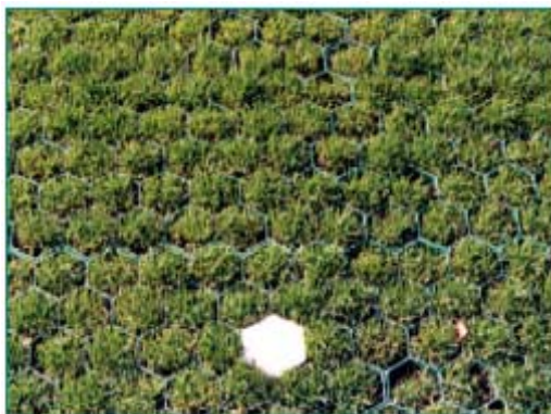
Figura 2.44 - I fori tra cella e cella consentono all'erba una più libera e completa radicazione al terreno ed un ottimo drenaggio in caso di pioggia abbondante.
