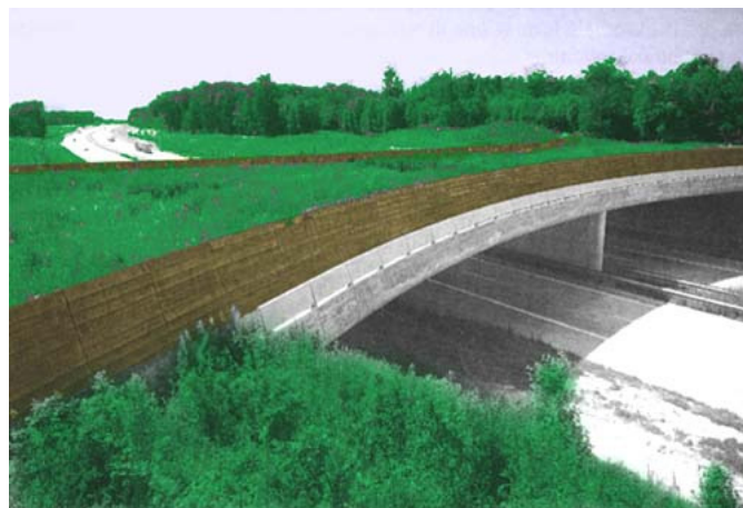
Fig. 5-2 - Esempio di sovrappasso su un'autostrada- Infra Eco Network Europe
