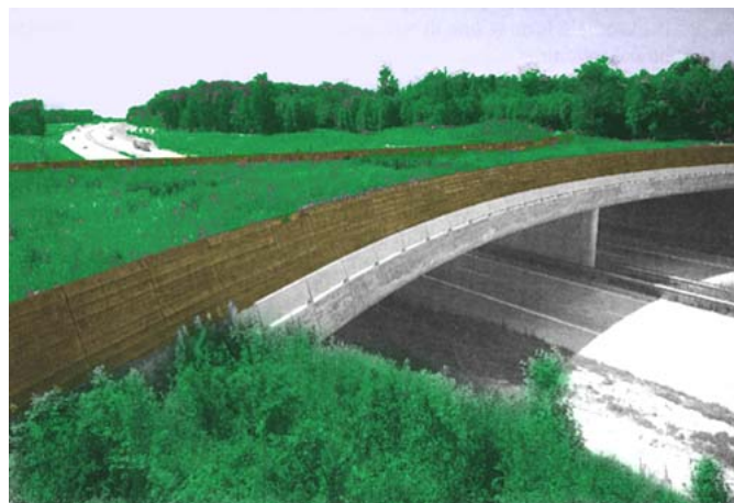
Figura 2.29 - Esempio di sovrappasso su un'autostrada- Infra Eco Network Europe
