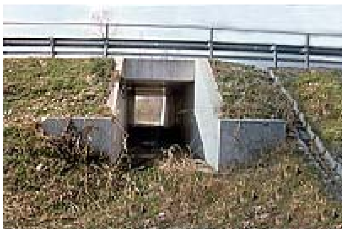
Figura 2.35 - Esempio di sottopasso rettangolare in cui è necessario inserire fasce di vegetazione laterali che fungano da elementi di invito verso il passaggio- Infra Eco Network Europe
