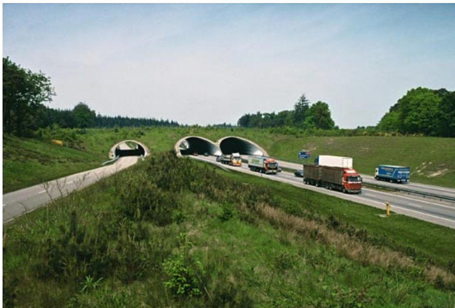
Figura 2.38: Esempio di ecodotto- Infra Eco Network Europe
