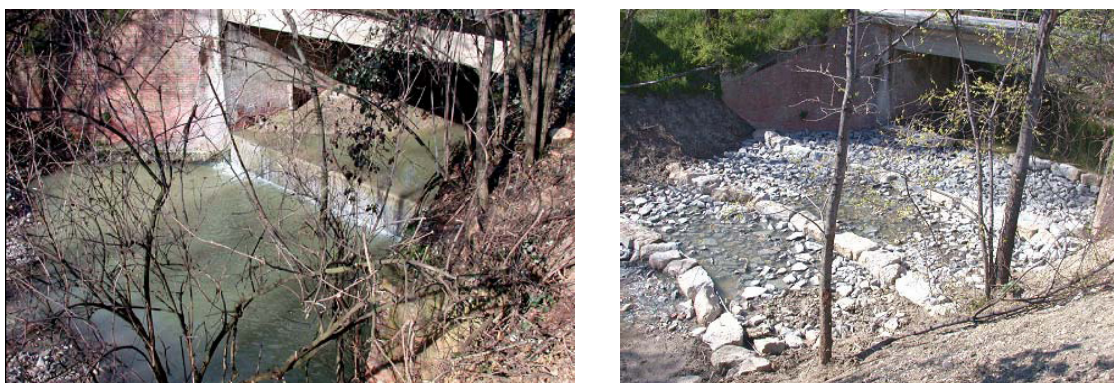
Fig. 3-3 - Esempio di costruzione di rampa in pietrame in Valsellustra (Pianificazione e realizzazione di metodi integrati per il recupero del bacino idrografico della Val Sellustra LIFE00 ENV/IT/000065 Comune di Dozza Newsletter n°6).
