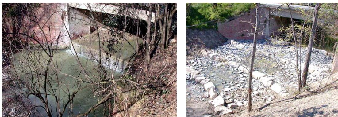
Figura 2.19 - Esempio di costruzione di rampa in pietrame in Valsellustra (Pianificazione e realizzazione di metodi integrati per il recupero del bacino idrografico della Val Sellustra LIFE00 ENV/IT/000065 Comune di Dozza Newsletter n°6).
