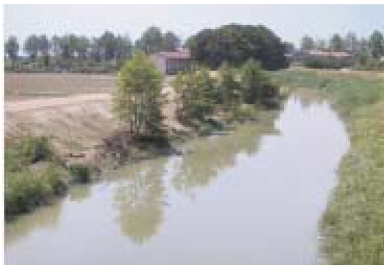
Figura 2.9 - Esempio di manutenzione effettuata preservando una serie di ontani presenti sulla sponda.
