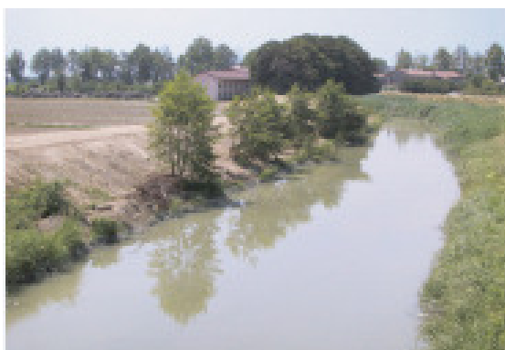
Figura 4.1 - Esempio di manutenzione effettuata preservando una serie di ontani presenti sulla sponda.
