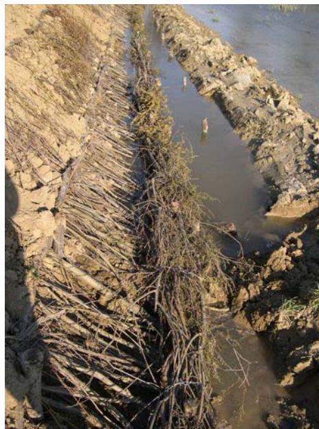
Esempio di copertura diffusa con ramaglia viva applicata lungo le sponde della parte terminale del Fiume Uso (RN)
