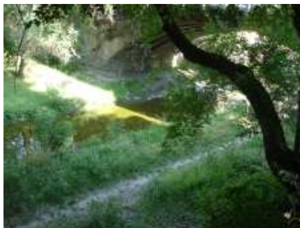
Figura 8.12 - Torrente Lavino sotto il ponte della strada statale di Vignola
