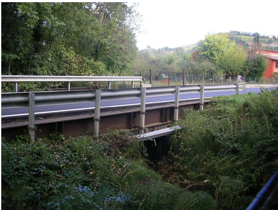
Figura 7.4 – imbocco del sottopasso sul Fosso Cimisella, guardando verso valle
