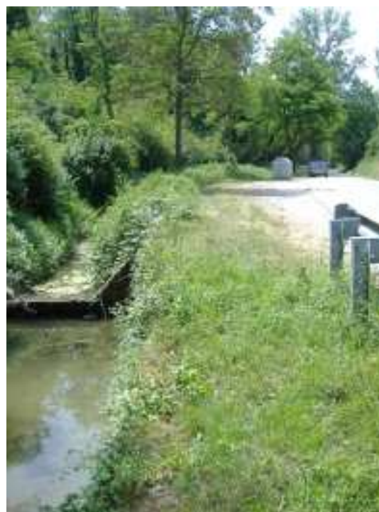
Figura 16-3 - Intervento 16.1a-torrente Ghironda su via Leonardo da Vinci presso Cà dei Ladri
