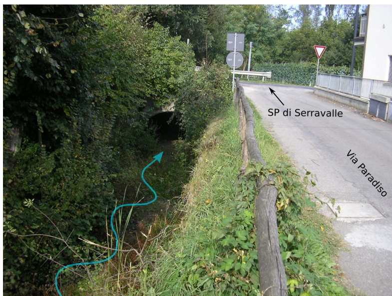
Figura 7.6 – sottopasso del Rio del Malpasso, guardando verso valle
