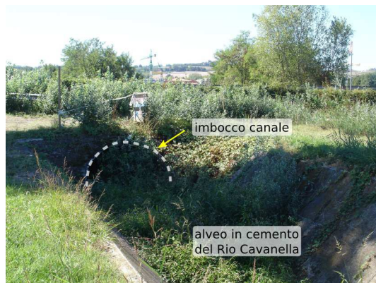
Figura 1-22– Sottopasso C, ripreso da nord
