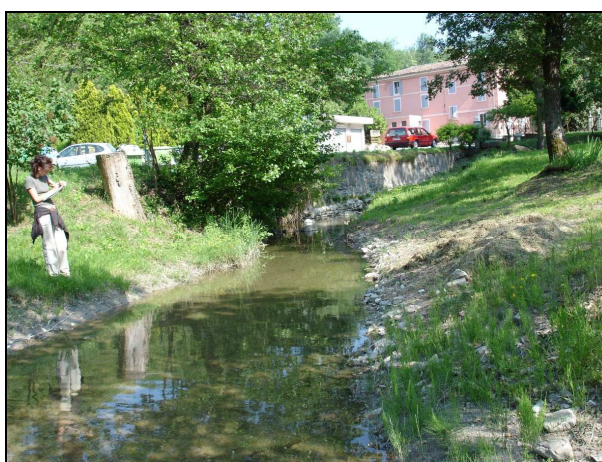
Lavino presso la località Padova: la strada si sviluppa a ridosso del torrente limitandone l'evoluzione naturale e apportando carichi inquinanti in alveo
