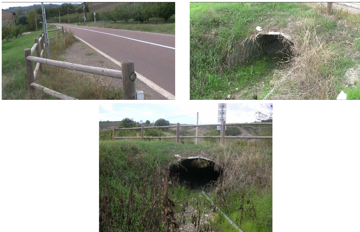
Figura 9.5 – immagini dell'attraversamento idraulico del Rivo Sega (pressi di Savigno)
