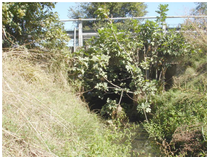
Figura 3-4 – Imbocco sud del canale sotterraneo del Cavanella sulla A1 Dimensioni: circa 5 m di ampiezza per 2,5 m di altezza.
