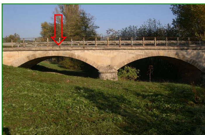
Possibile passaggio utilizzato dalla fauna per oltrepassare la strada
