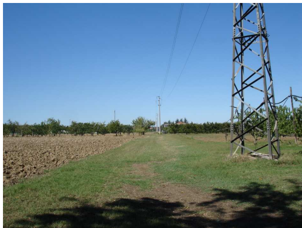
Figura 1-24 - a sud del sottopasso A, direzione ovest
