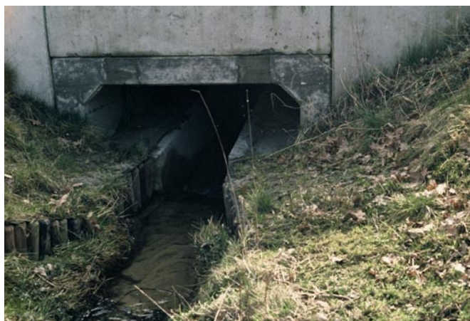
Fig. 5-12 - Esempio di eco-culvert con passerelle laterali per fauna di piccole dimensioni- Infra Eco Network Europe
