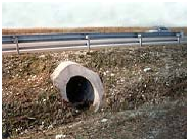
Figura 2.28 Esempio di sottopasso faunistico (non completamente funzionale) per piccola media fauna - Infra Eco Network Europe
