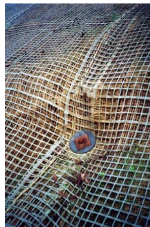
particolare del solco per il fissaggio del biotessile nel terreno tramite picchetto in ferro
