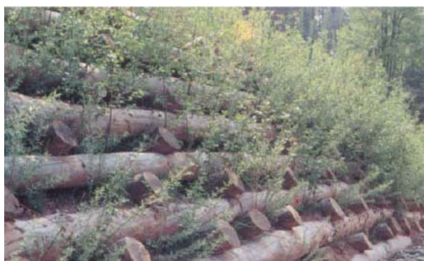
Esempio di palificata 2 anni dopo la realizzazione- foto tratta da Provincia di Como-Studio geologico ambientale del torrente Lanza
