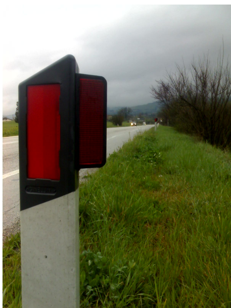
Fig. 5-18 - Dissuasore riflettente per la fauna selvatica montato su paracarro lungo una strada provinciale.
