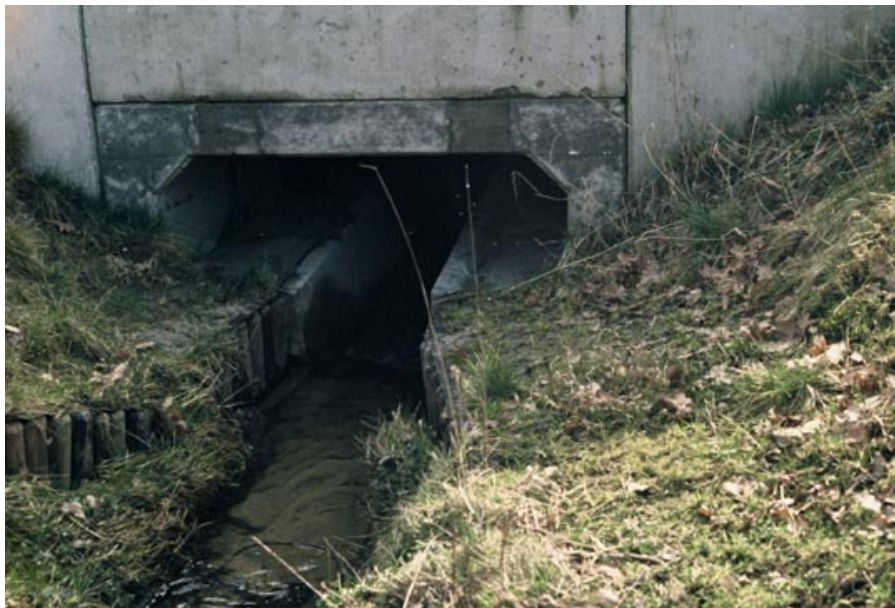
Figura 2.39 - Esempio di eco-culvert con passerelle laterali per fauna di piccole dimensioni- Infra Eco Network Europe
