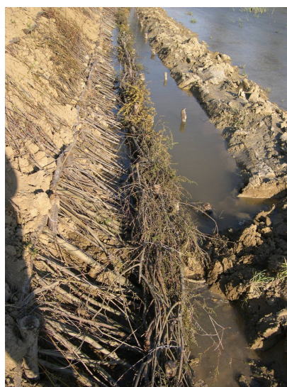
Fig. 3.3 - Esempio di copertura diffusa con ramaglia viva applicata lungo le sponde della parte terminale del Fiume Uso (RN)
