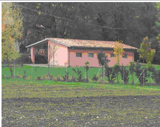
6. Capannone agricolo, Località Badia
